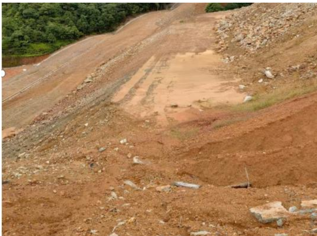
弃土场东侧+374m 平台
