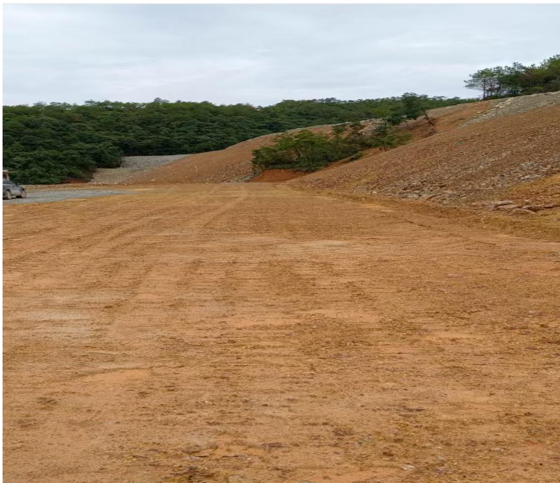
弃土场东侧+384m 平台
